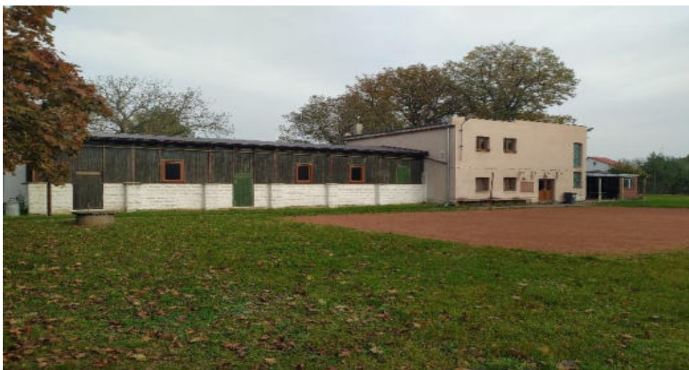
Dřevěná tělocvična se zděnou přístavbou v areálu TJ Sokol
